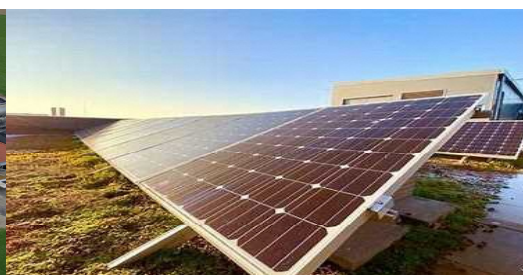
湿地に設置された太陽光パネル
