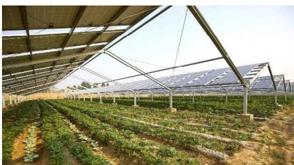
野菜畑の上に設置した太陽光発電（PV）一パネル
