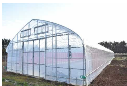
パイプハウス
