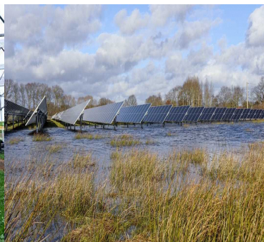
湿地でのソーラーパネルの設置
