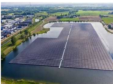
沼に浮遊式のソーラーパネルで太陽光発電
