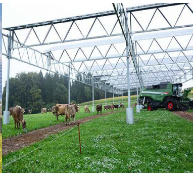
ソーラーパネルを高くして牛の放牧とトラクターの作業も可能
