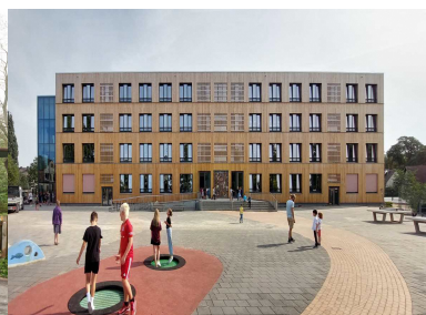
建物改修部門・小学校 (ノイルーピン)
