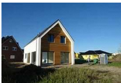
木材ハイブリット構造の住宅 木材とセメントを使った建物
