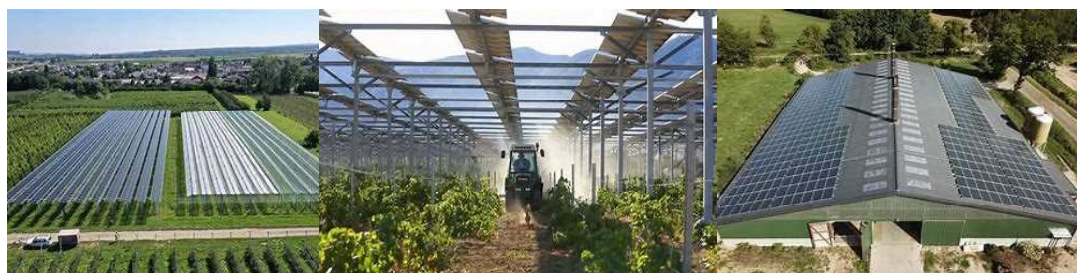
農地に設置した太陽光 PV 高く設置したパネルの下で 畜舎の屋根に設置された PV トラクター作業も可能に。
